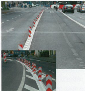
Leitschwelle/ Guide barrier
