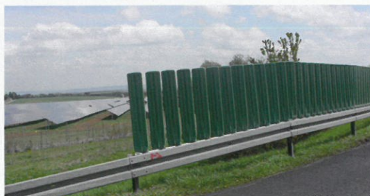
Reflektionsschutz bei Solarfeldern Reflection protection in solar fields
