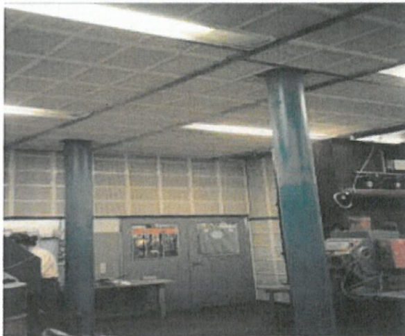
Lärmschutzwand in Fertigungshalle
