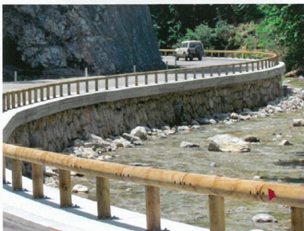
2 Meter - Pfostenabstand mit Fußplatte
