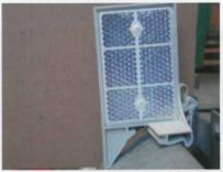
Kunststoffkörper mit Clip System auf Schutzplanke Typ A, Kunststoffreflektor 120 x 80 mm, einseitig oder beidseitig
