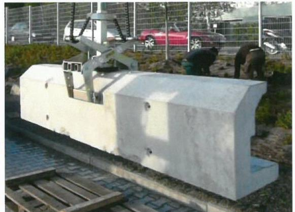
Bei diesen Bauteilen wird, deutlich über die Forderungen des MAmS hinaus, ein mehrfacher Überkletterschutz mit integrierter Tropfkante zum Einsatz gebracht. Aufgrund der offenen L-Form besteht für Jungtiere nicht die Gefahr, auf der Lauffläche festzukleben und zu vertrocknen, bzw. adulte Tiere durch die unbehandelten Laufflächen Verätzungen an den Tarsalgliedern und den Bauchlappen davon zu tragen.
